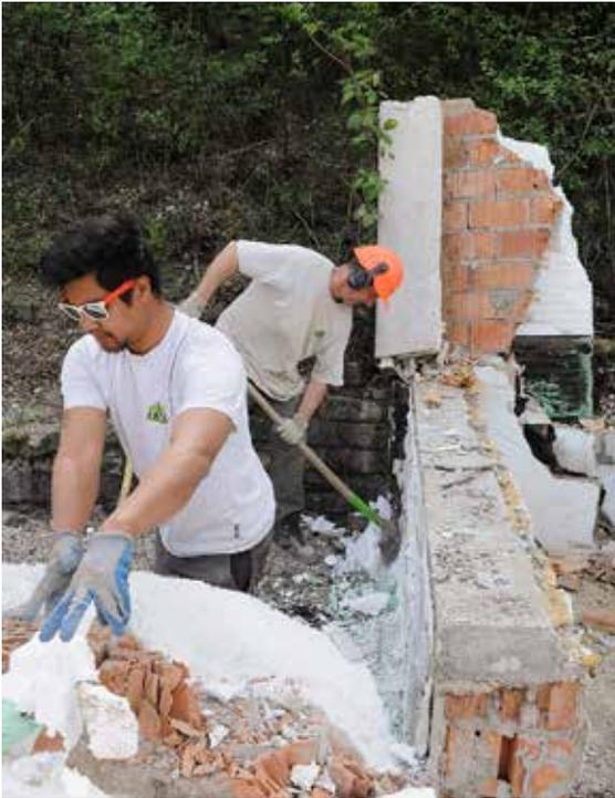
Beim Rückbau eines Gebäudes werden alle Materialarten getrennt. Zwei Arbeiter entfernen von Hand weisse Sagex-Isolation, die später der Energierückgewinnung beziehungsweise der Verbrennung zugeführt wird.
